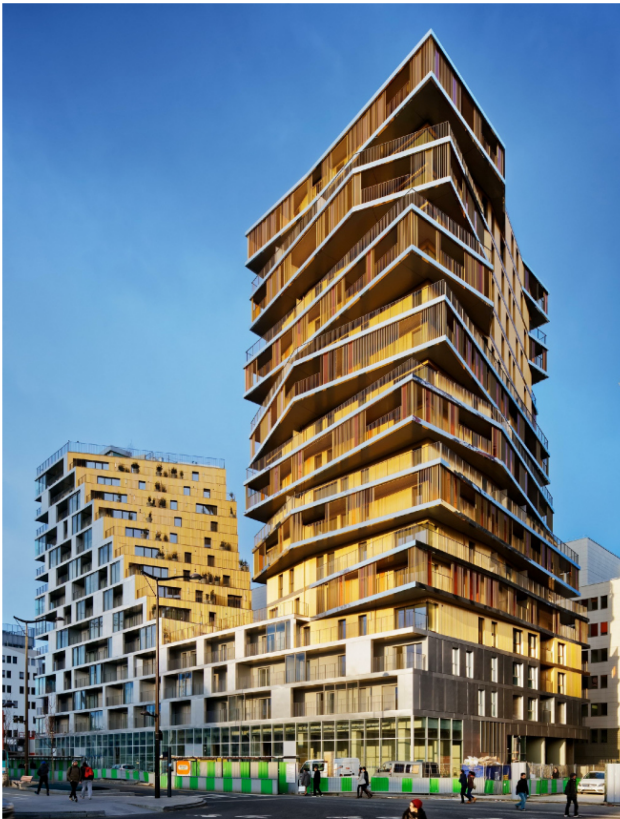
Рисунок 9. Общий вид жилого комплекса
