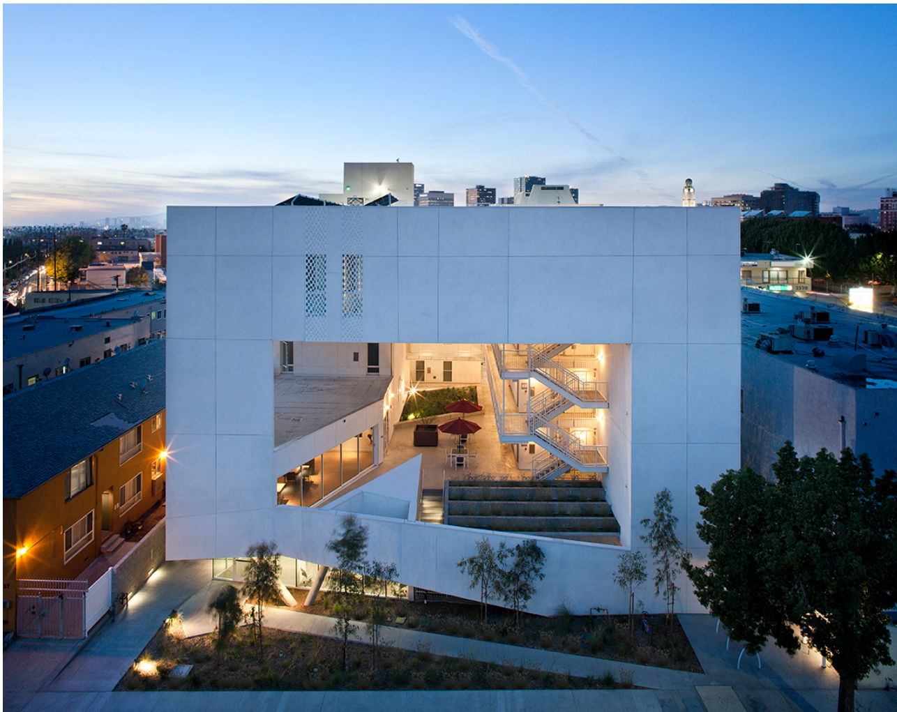
Рисунок 11. Общий вид многоквартирного жилого дома
