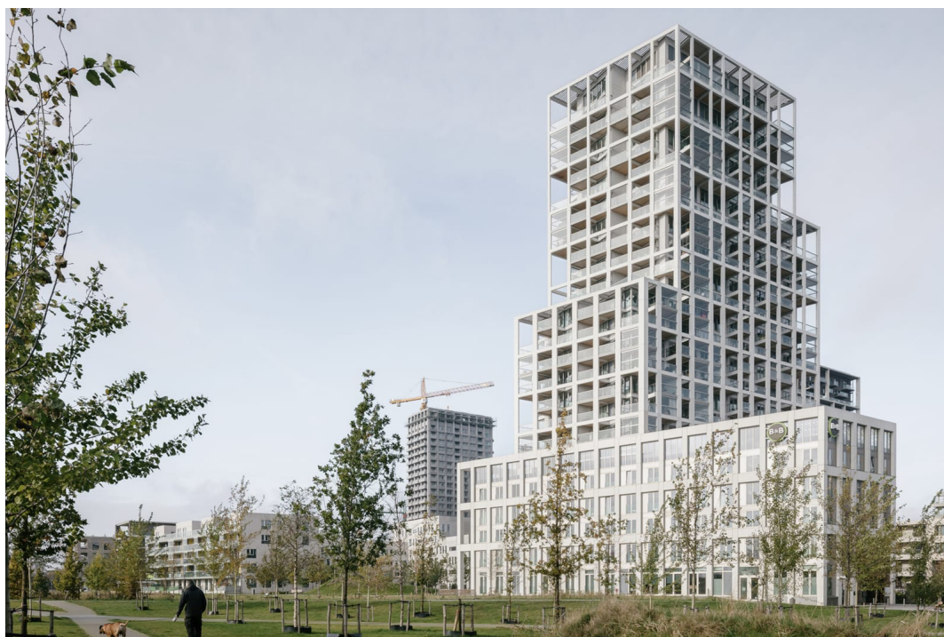
Рисунок 3. Общий вид жилого комплекса
